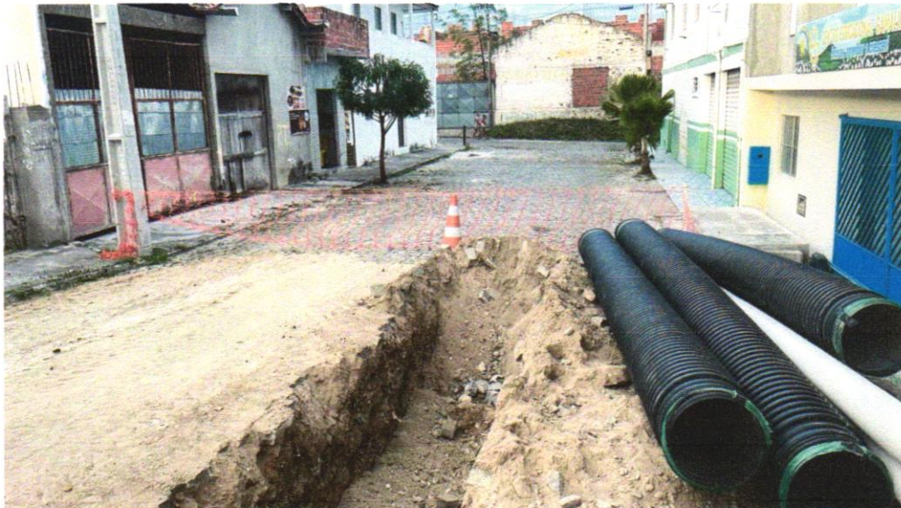
Foto 03 - ESCAVAÇÃO DE VALA
