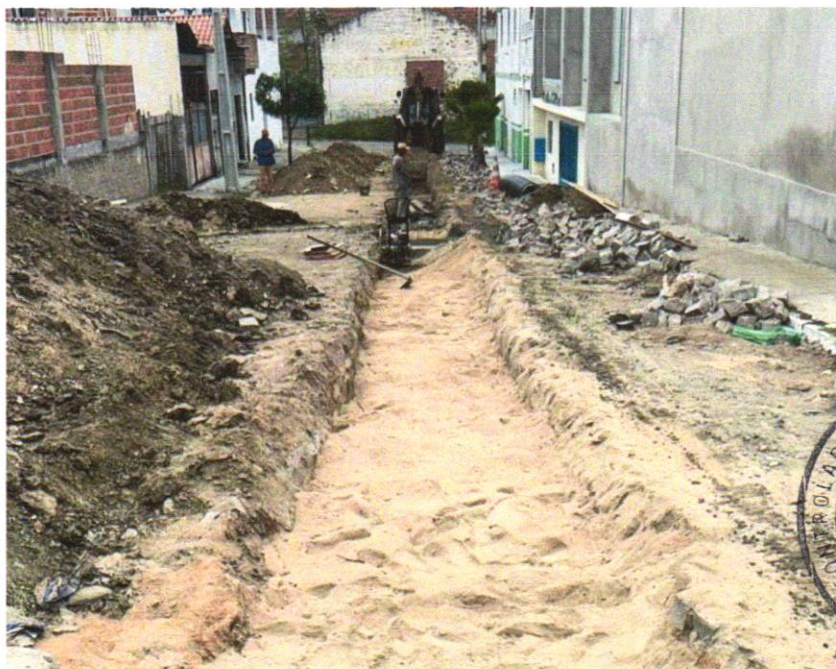
Foto 04 - ATERRO MANUAL COM SOLO ARGILLO-ARENOSO IMPORTADO E COMPACTAÇÃO MECANIZADA EM CAMADAS DE 0,20 M NO MÁXIMO
