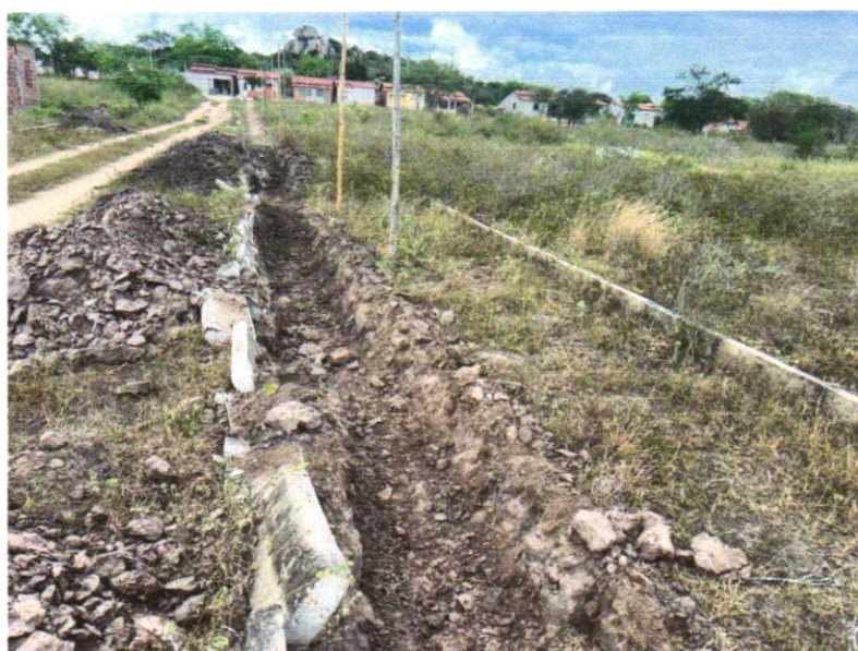
Foto 02 – ESCAVAÇÃO DE VALA
